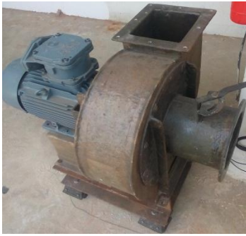
CENTRIFUGAL BLOWER (MS + FRP)
