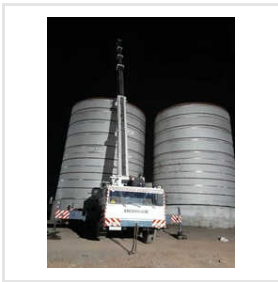
100 Ton Crane Liebherr
