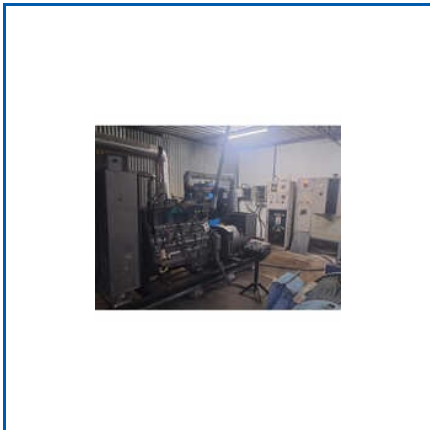
125 KVA BIOGAS GENERATOR
