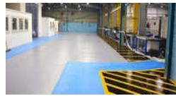
Pu Concrete Flooring
