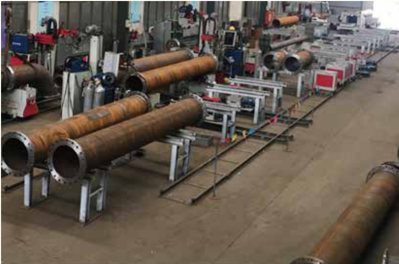
装配式机房管道预制(上海客户现场)
