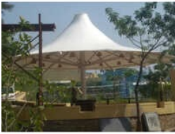
Cone Tensile Structure
